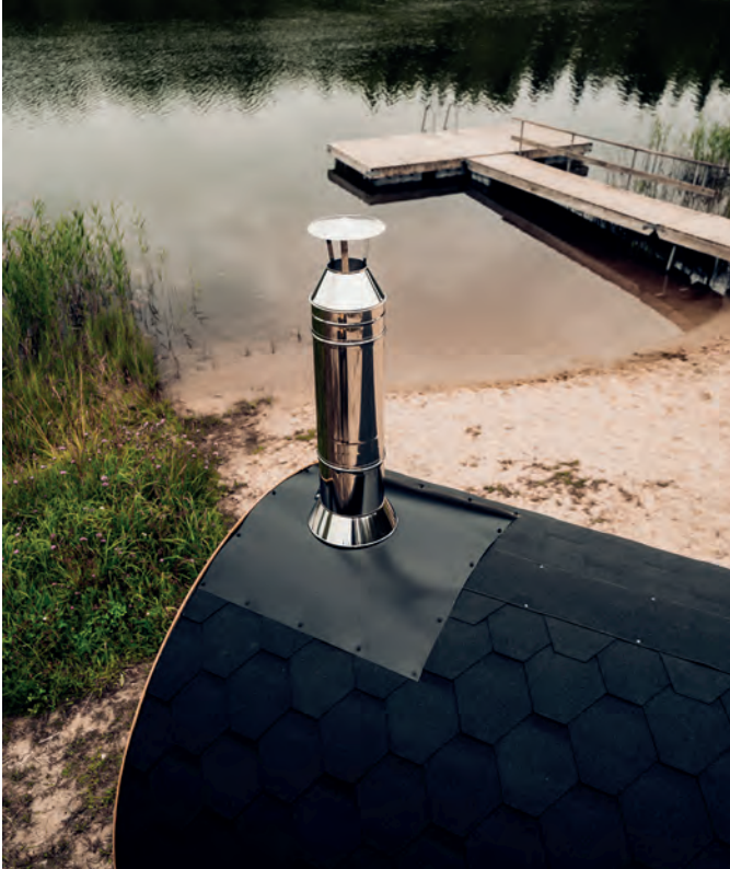
AFWERKING SCHOUW DAKZIJDE
