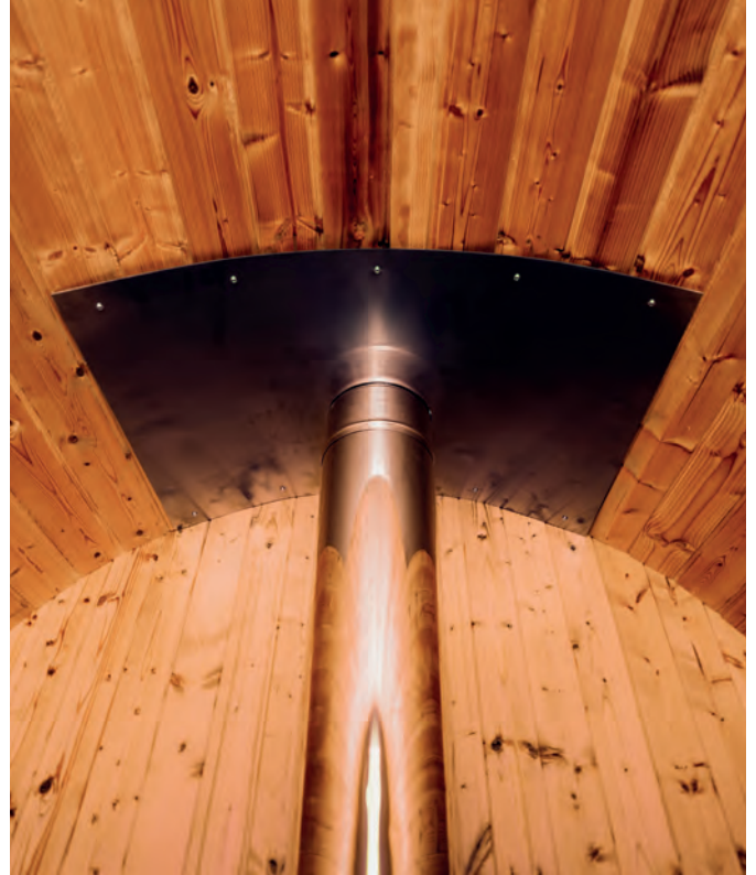
AFWERKING SCHOUW BINNEN
